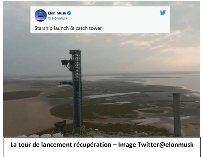
puissance. La tour est donc équipée de gigantesques bras robotiques en forme de pinces de 36 mètres de long qui doivent encercler le booster de 200 tonnes lors de son approche (millimétrée !). Ils seront ouverts de 30 degrés pendant un vol stationnaire de 5 secondes, et se refermeront.
